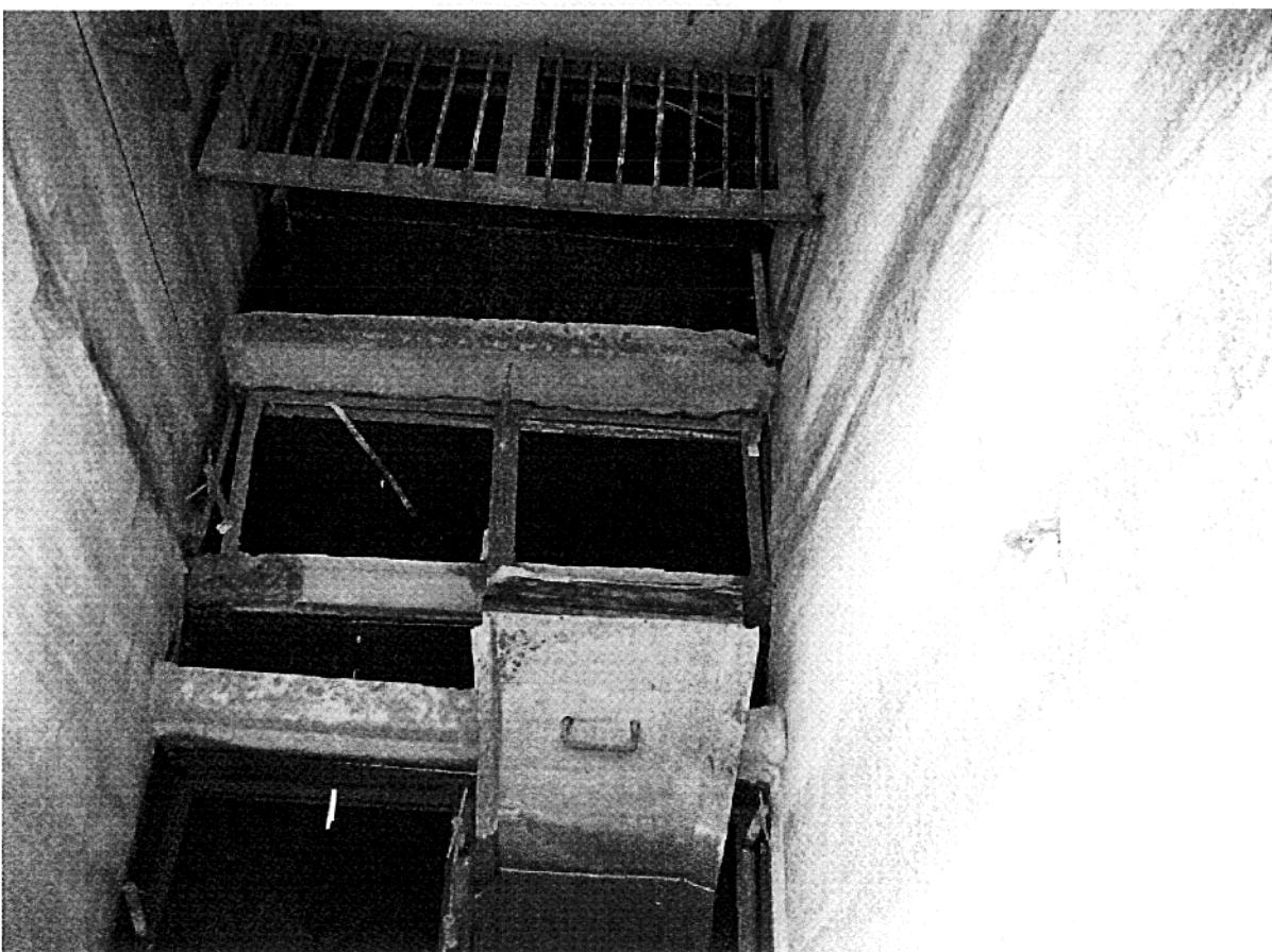
Рис.4.6.4. Очистное сооружение индивидуального проектирования кассетного типа (секция очистки ливневых сточных вод)
