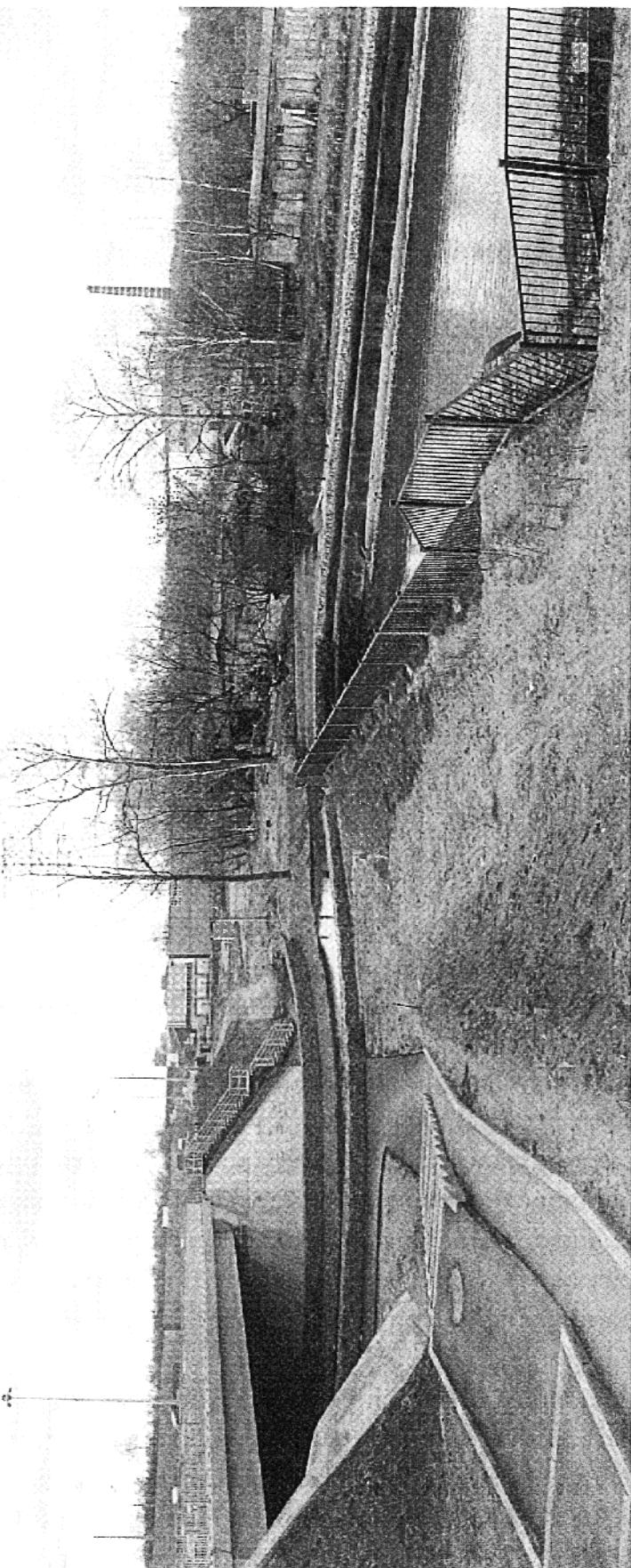
Рис. 4.1.8. Очистное сооружение (пруд-отстойник каскадного типа)
