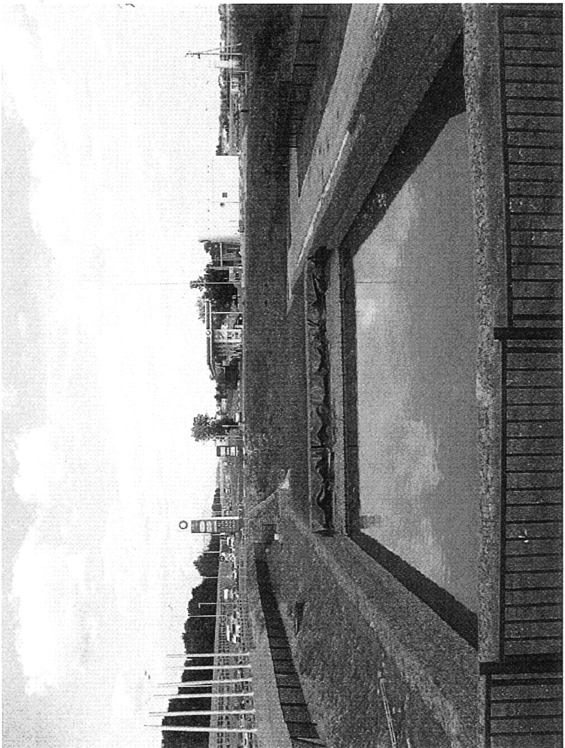
Рис. 4.1.6. Очистное сооружение каскадного типа с использованием габионов (вид сверху)
