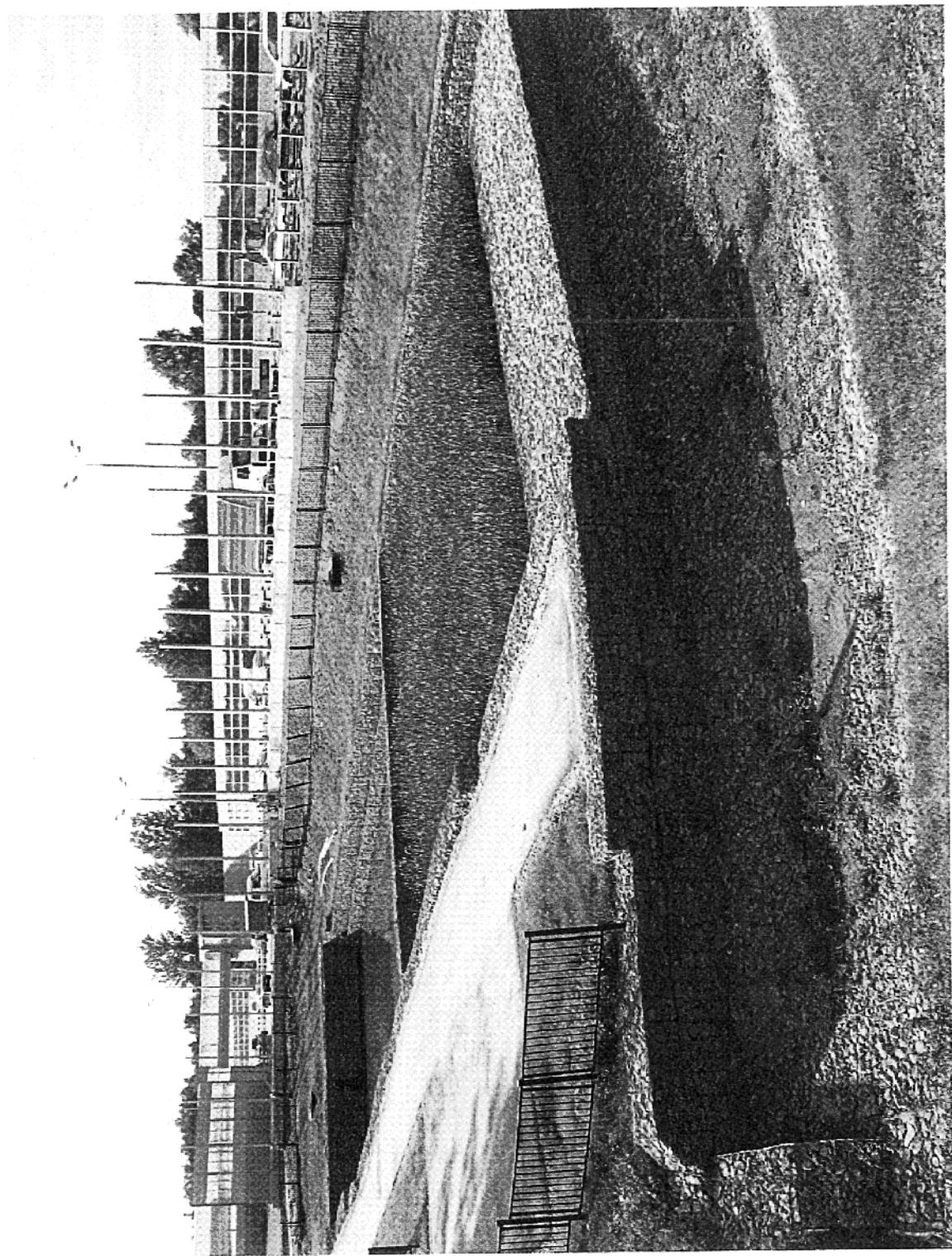
Рис. 4.1.5. Очистное сооружение каскадного типа с использованием габионов (вид сбоку)
