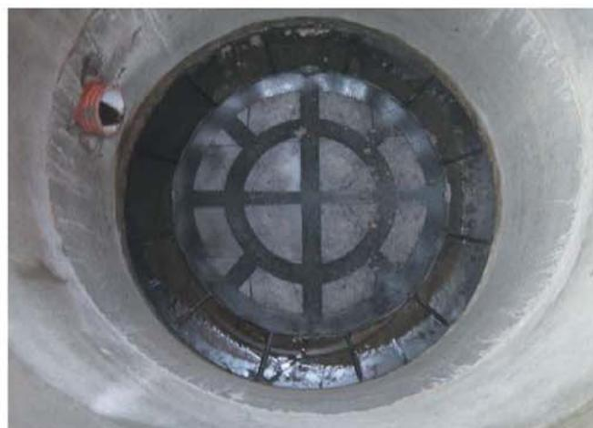
**Рис. 7. Внешний вид верхней решетки фильтра ФОПС®-МУ-2,0-1,2 в канализационном колодце после 21 месяца работы**
