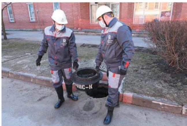
Рис. 4. Выемка фильтра ФОПС®-К-0,58 из канализационного колодца
