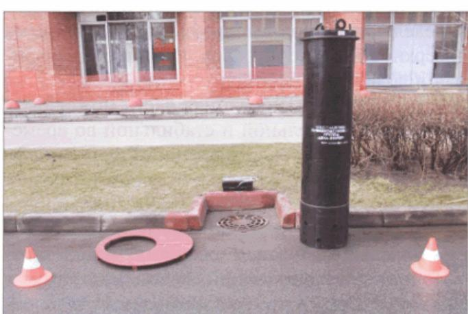
**Рис. 2. Внешний вид фильтра ФОПС®-МУ и разборного опорного кольца перед установкой их в канализационный колодец**
