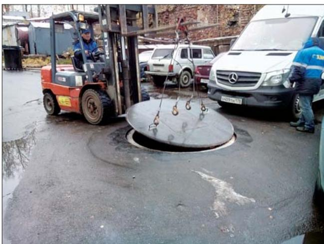
Рис. 3. Удаление легкоъемной крышки с верхней части канализационного колодца
