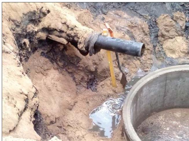
Рис. 6. Внешний вид раскопа котлована для обустройства канализационного колодца с просачиванием грунтовых инфильтрационных вод различного происхождения
