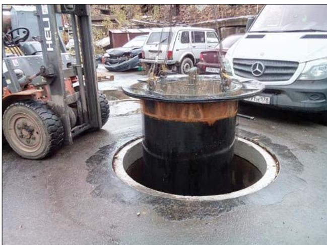
Рис. 4. Удаление фильтра ФОПС®-Ц-1,5-1,2 из канализационного колодца при помощи автопогрузчика
