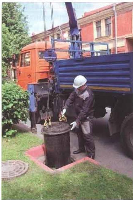
Рис. 1. Размещение (или удаление) фильтра ФОПС®-МУ-0,58-1,8 внутри канализационного колодца с помощью автоманипулятора
