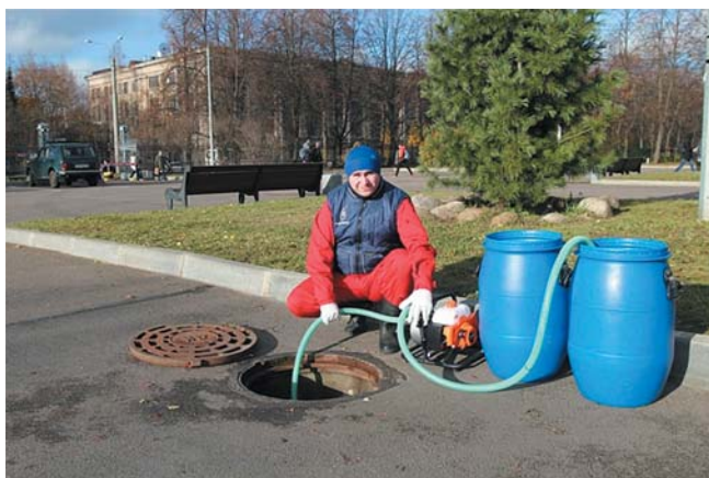
Рис. 6. Откачка жидких нефтепродуктов, накопившихся в фильтре ФОПС®-С
