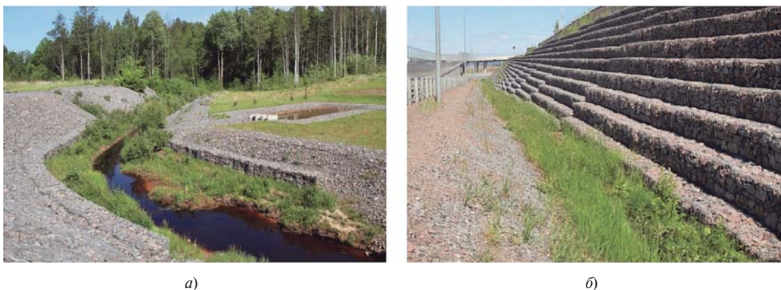
Рис. 1. Внешний вид габионных конструкций для укрепления склонов на КАД СПб: а — берега реки Каросты; б — откосы на двухъярусной автотрассе
