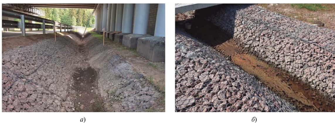
Рис. 5. Заиление нерастворимыми соединениями железа канав на основе ГСК на трассе М11 (Санкт-Петербург—Москва):
