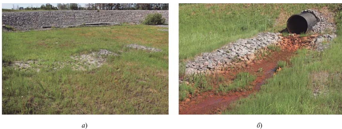
Рис. 6. Результаты неудовлетворительной работы водотоков на основе ГСК типа матрацев Рено:
