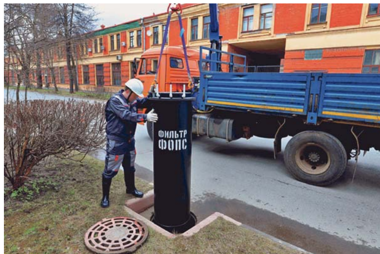
Рис. 11. Монтаж фильтра очистки поверхностного стока ФОПС в дождеприемный канализационный колодец на автодороге
